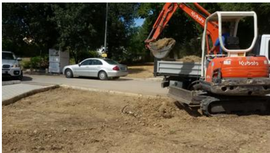
Realizzazione dello scavo di fondazione
